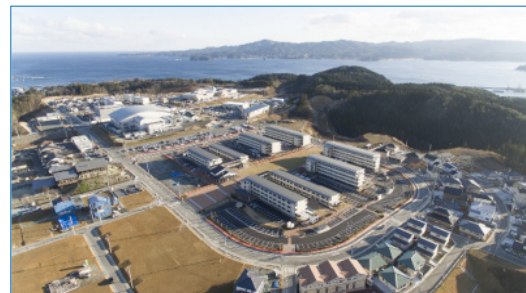
写真1 災害公営住宅
