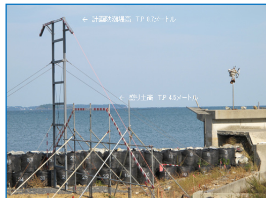
写真14 計画が進む防潮堤
