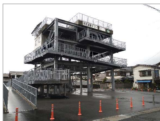
津波避難タワー
